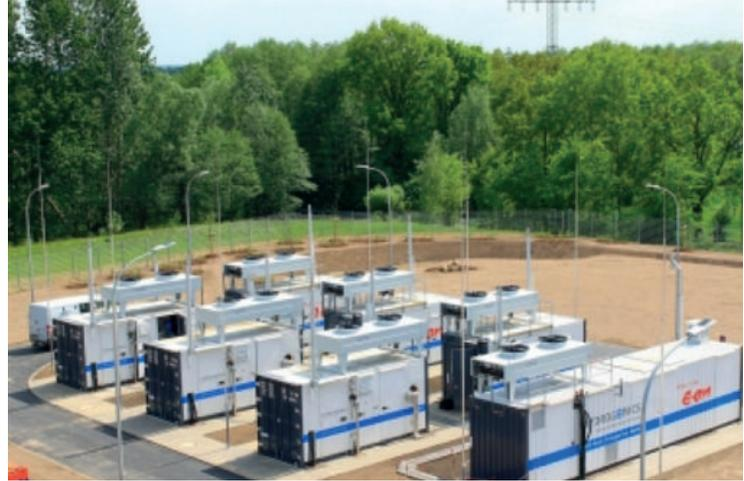
**E**l hidrógeno inyectado queda mezclado así con el gas natural que lleva la red “y puede ser utilizado para una gran variedad de aplicaciones, incluyendo calefacción, procesos industriales, movilidad, y la generación de energía”. La unidad de Falkenhagen, que tiene una capacidad de dos megavatios, puede producir -informa E.On- 360 metros cúbicos de hidrógeno por hora.
