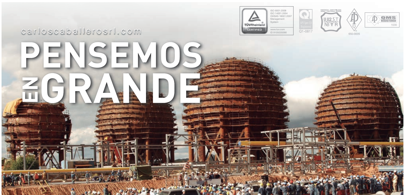
OBRA: Montaje de 4 tanques esféricos para almacenamiento de GLP de 7590 m 3 y 3 para almacenamiento de isopentano de 690 m 3 . CLIENTE: Felguera IHI S.A. CLIENTE FINAL: YPFB Corporación
