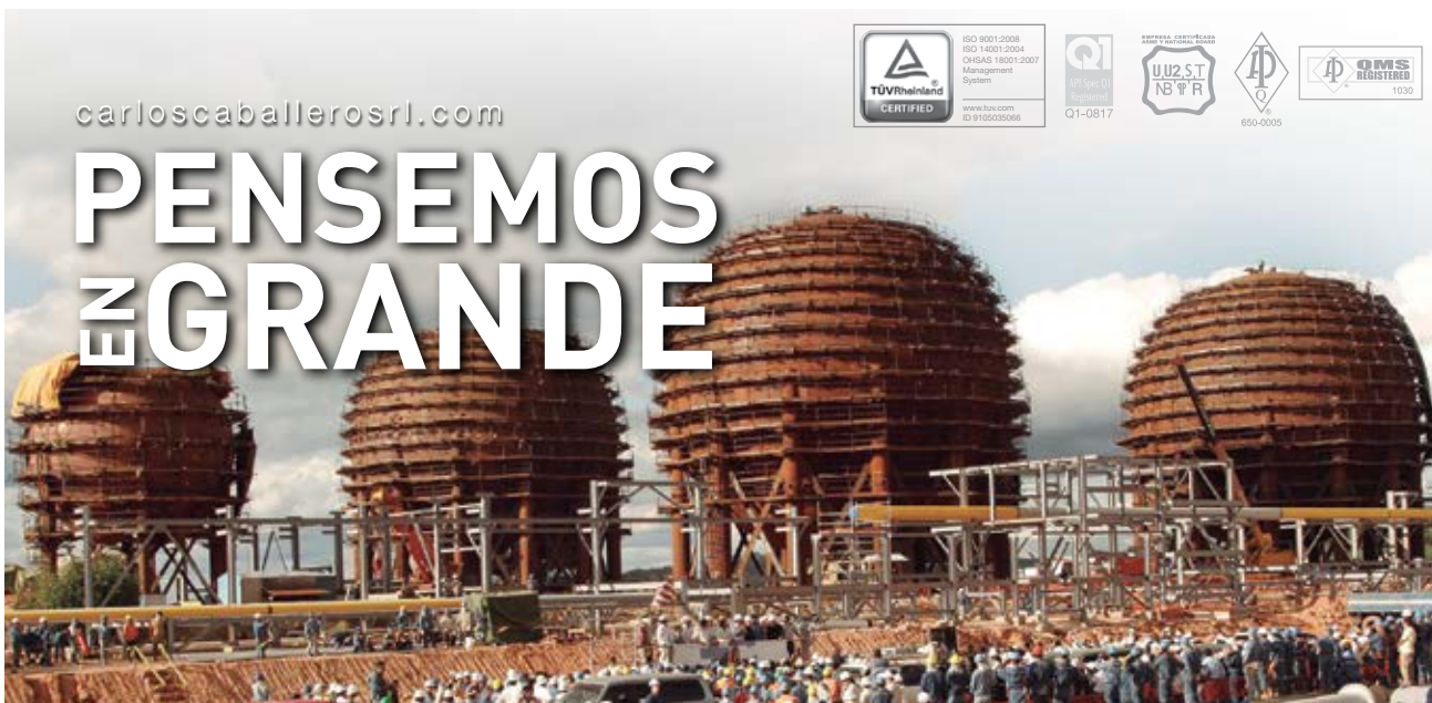
OBRA: Montaje de 4 tanques esféricos para almacenamiento de GLP de 7590 m3 y 3 para almacenamiento de isopentano de 690 m3. CLIENTE: Felguera IHI S.A. CLIENTE FINAL: YPFB Corporación
