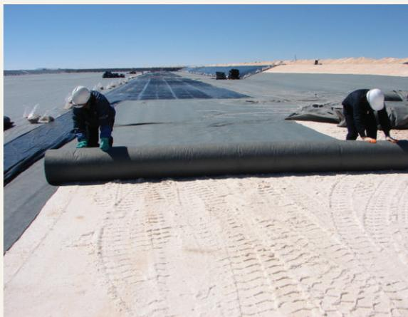
Las Geomembranas son un recubrimiento, una membrana o barrera de muy baja permeabilidad aplicada a la ingeniería geotécnica para controlar la migración de fluidos. Las Geomembranas son hechas a partir de hojas relativamente delgadas de polímeros como HDPE o PVC. En general, son sistemas de impermeabilización para la construcción de túneles, canales, embalses, lagunas de oxidación, rellenos sanitarios y piscinas de recolección de lodos.
