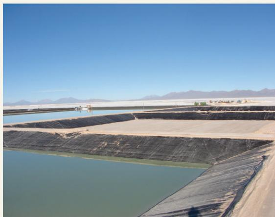
En respuesta a estas necesidades, Mexichem Soluciones Integrales, presenta las Geomembranas de Polietileno de Alta Densidad, (High Density Polyethylene HDPE) y las Geomembranas de Polietileno Ultraflexible, (LLDPE), como una solución para asegurar la impermeabilidad del terreno y de las estructuras de confinamiento dirigidas a una amplia gama de sectores industriales. En Bolivia el proyecto de industrialización del litio está utilizando estos materiales con una alta recurrencia.
