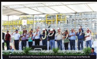
El presidente del Estado Plurinacional de Bolivia Evo Morales, en la entrega de la Planta de Licuefacción de Gas Natural (GNL)
